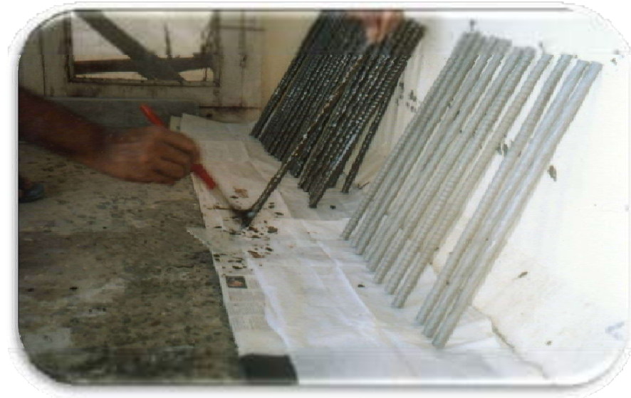
Application of Primer Coat
